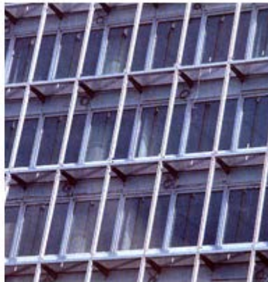
Σχήμα 6.7.6. Δικέλυφα κτήρια. Δημιουργία αεριζόμενης πρόσοψης
