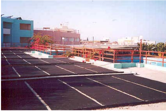
Σχήμα 2.7. Απλοί πλαστικοί ηλιακοί συλλέκτες τοποθετημένοι οριζόντια για την θέρμανση του νερού πισίνας σε ξενοδοχείο.
