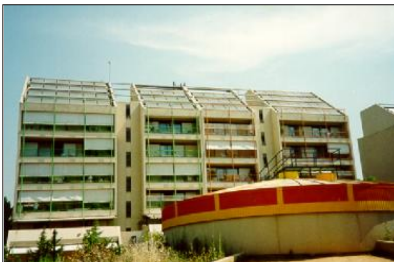
Σχήμα 2.20. Συγκρότημα κατοικιών στο Ηλιακό Χωριό, με ηλιακούς συλλέκτες κενού και διεποχιακή αποθήκη θερμότητας.
