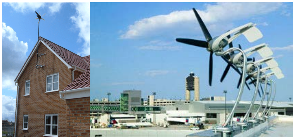
Σχήμα 6.11: Τοποθέτηση Α/Γ επάνω σε κτήρια.
