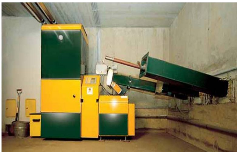
Σχήμα 4.4: Διάταξη λέβητα στερεού καυσίμου
