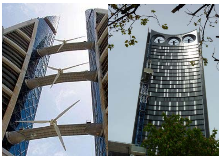
Σχήμα 6.12: Ενσωμάτωση Α/Γ σε κτήρια.
