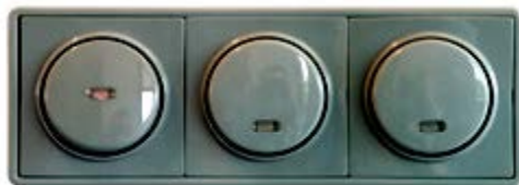
Σχήμα 3.2.9. Τυπικός διακόπτης πίεσης (push-button) και απλός διακόπτης
