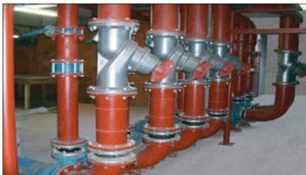
Εικόνα 3.2.7. Βαλβίδες υδραυλικής εξισορρόπησης δικτύων θέρμανσης – κλιματισμού.
